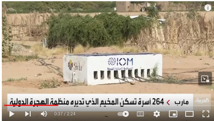
مبنى يحمل علامة واضحة للمنظمة الدولية للهجرة داخل مخيم الحمة. المصدر: العربية
